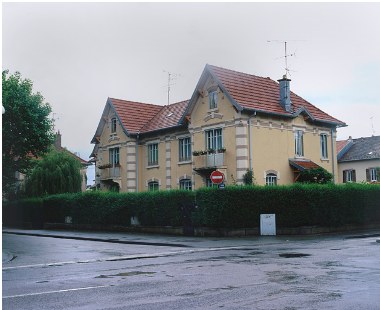
Logement double de contremaître rue d'Alsace.
