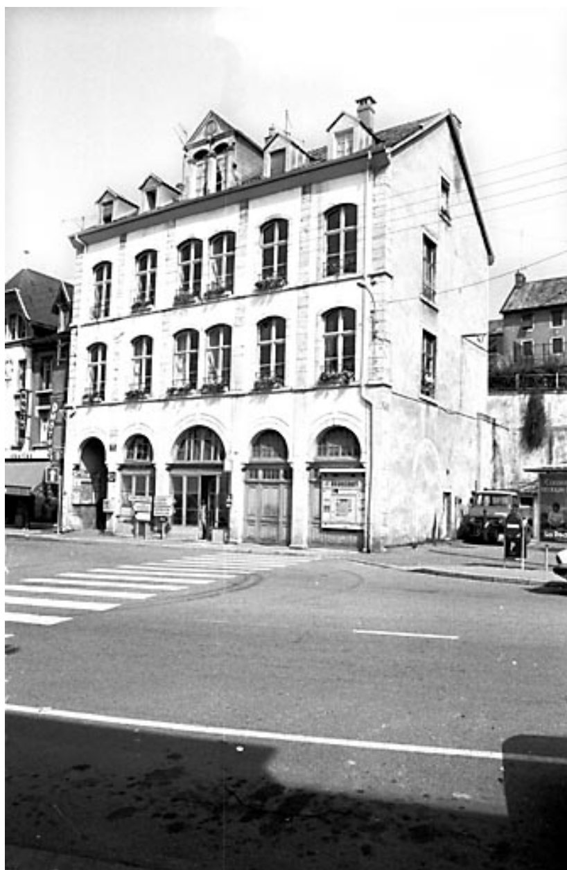
Façades antérieure et latérale droite.
