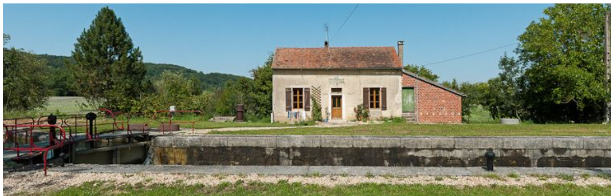
Vue de face de la maison éclusière.
