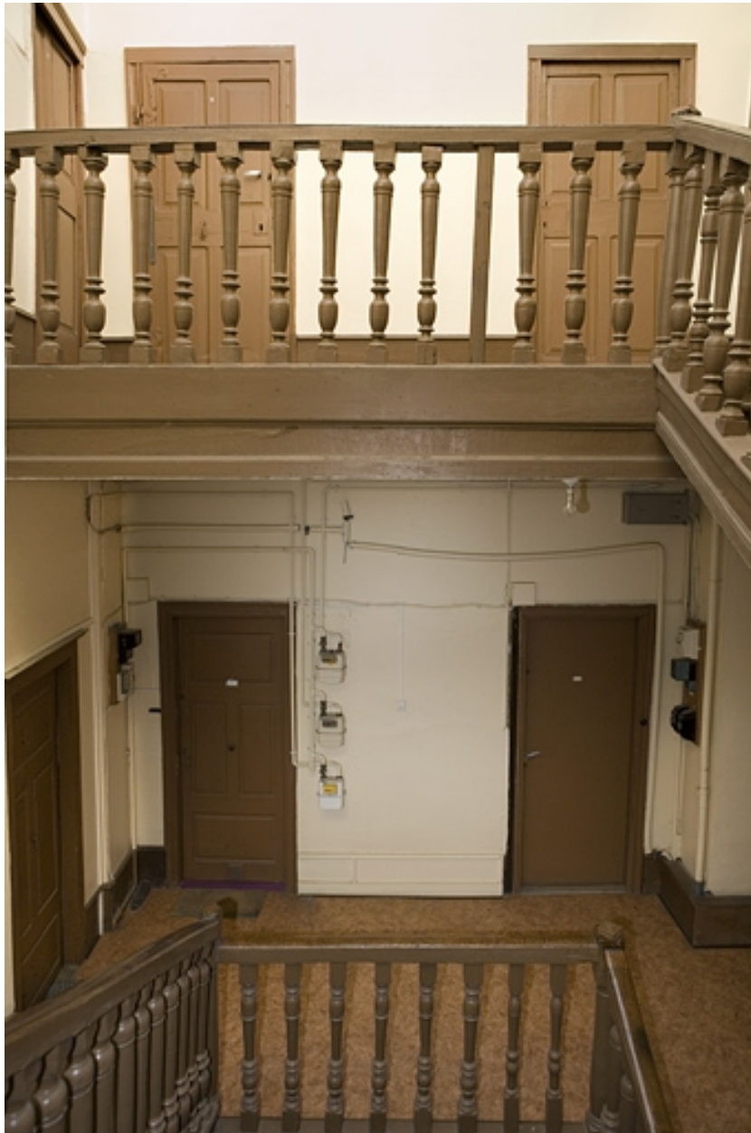
Détail de la rampe de l'escalier.
