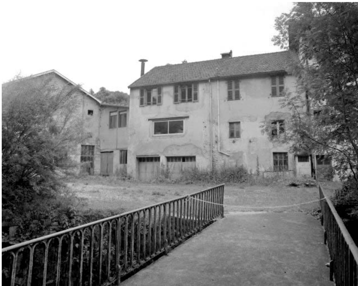
Façade postérieure du bureau et du logement.
