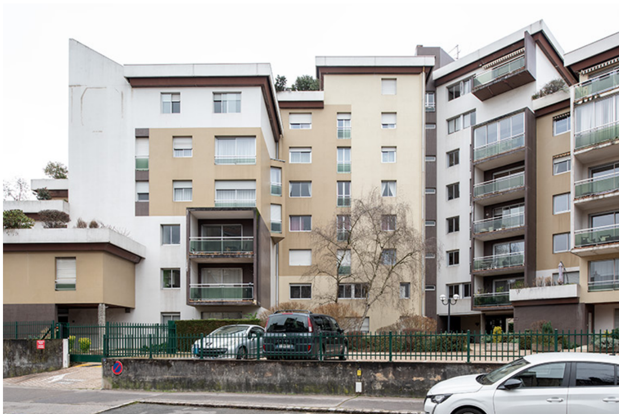
Aile nord, façade est.
