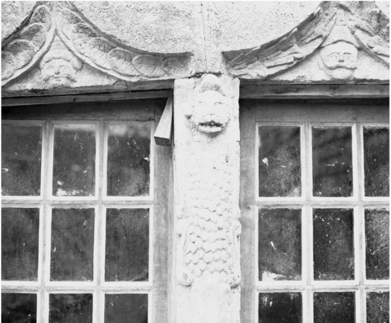
Détail du piédroit et des baies au rez-de-chaussée, côté cour.
