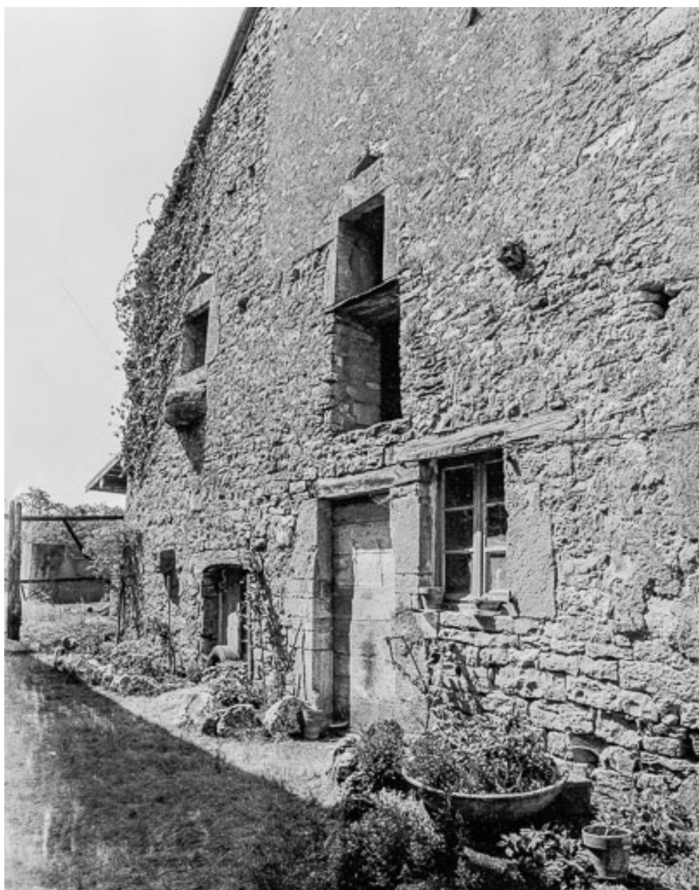
Maison située rue de Montbozon : détail de la face antérieure.
