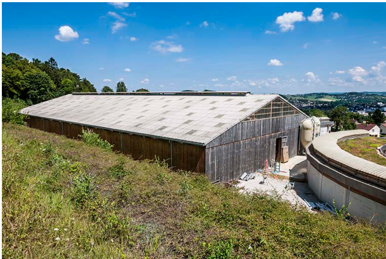
Centre équestre : toiture du manège.
