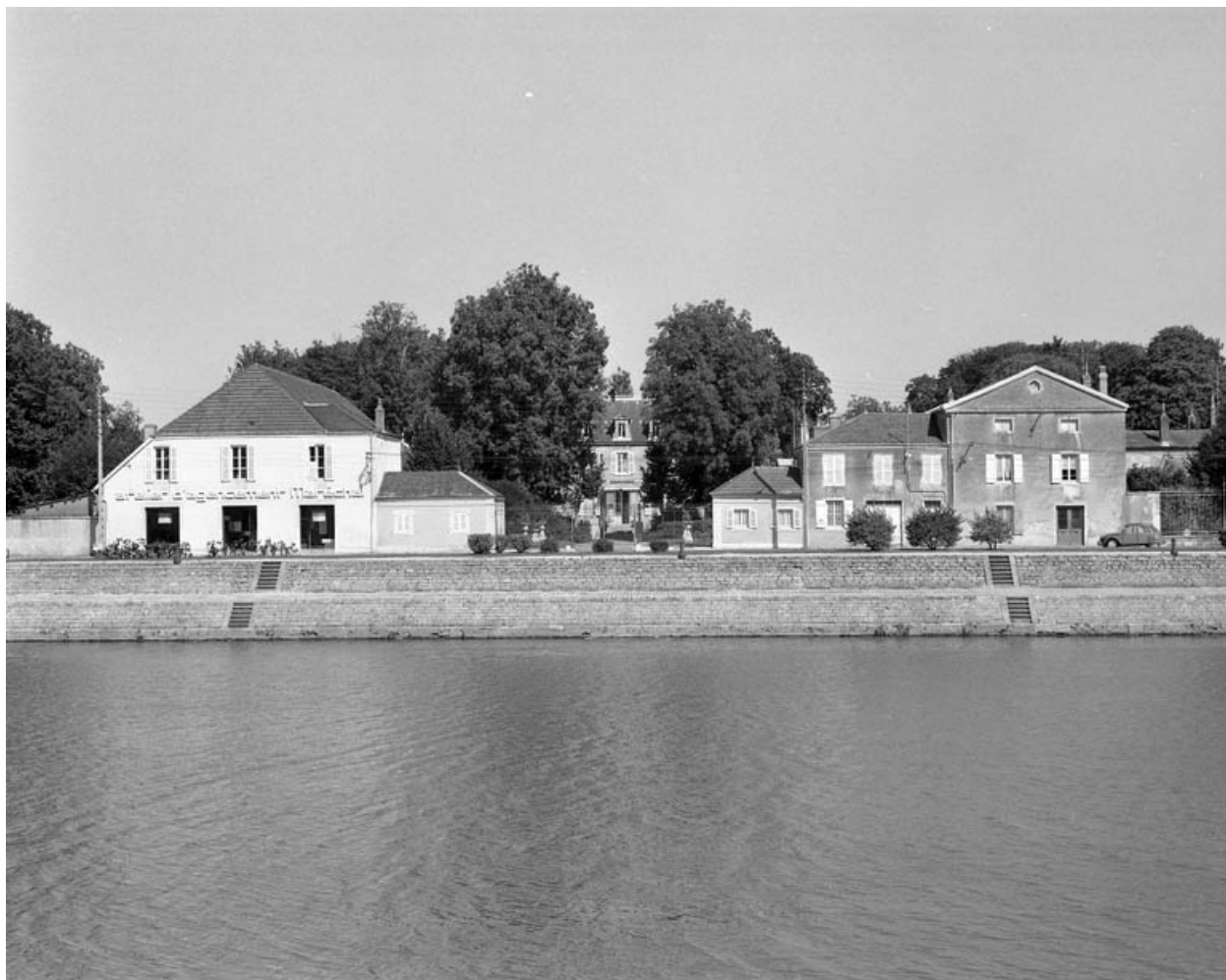
Vue d'ensemble depuis le quai Mavia.
