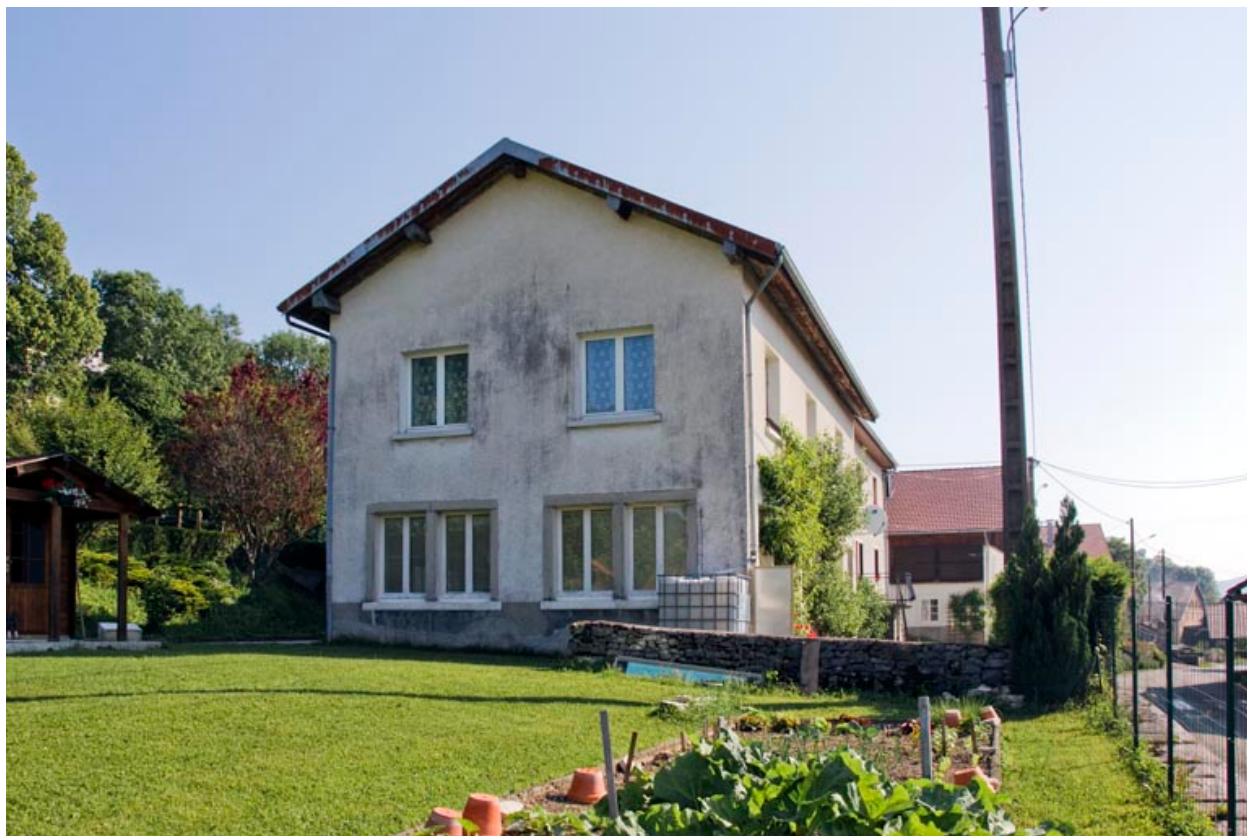
Façade latérale gauche de l'atelier.
