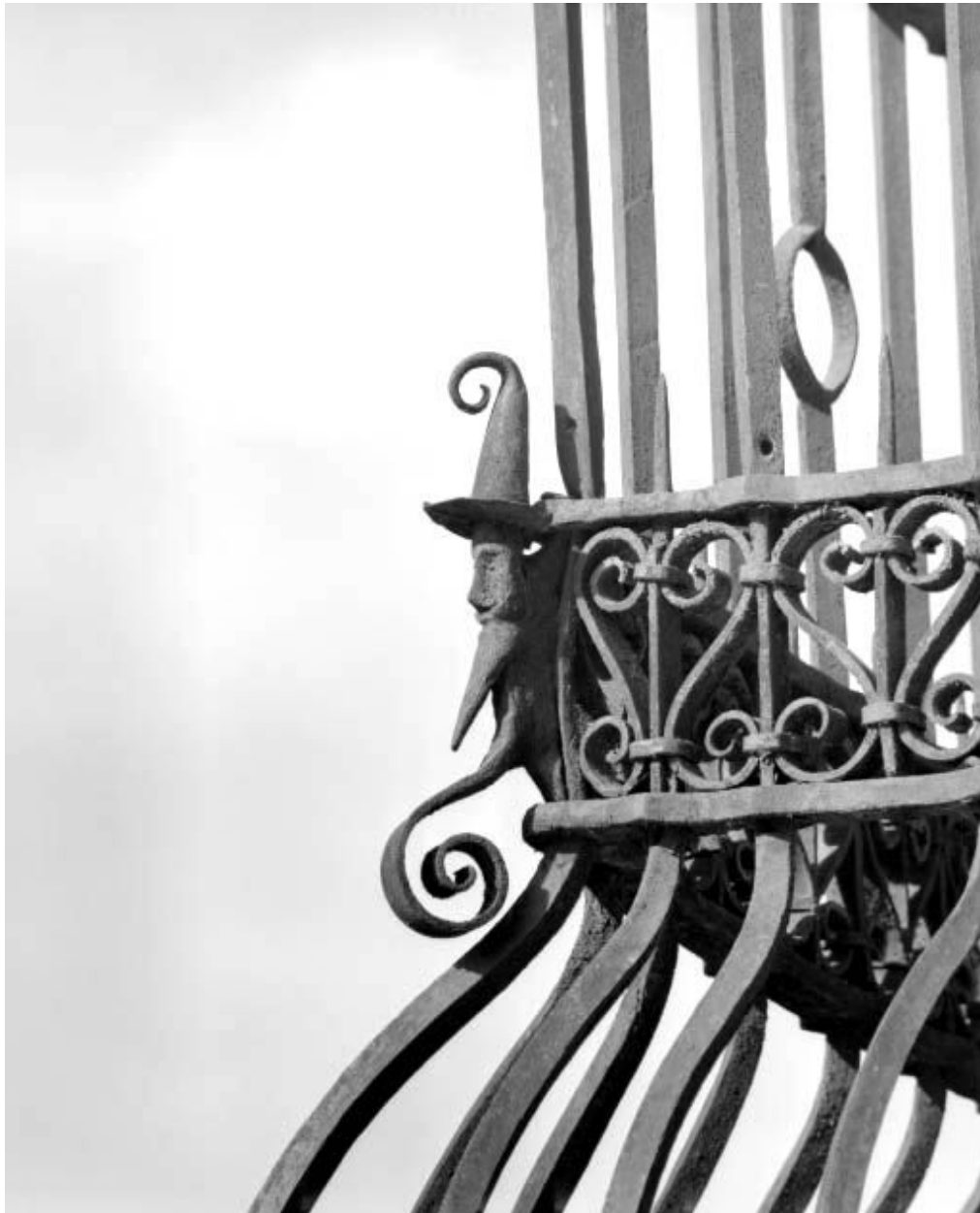
Façade antérieure, détail de la baie d'angle du rez-de-chaussée.
