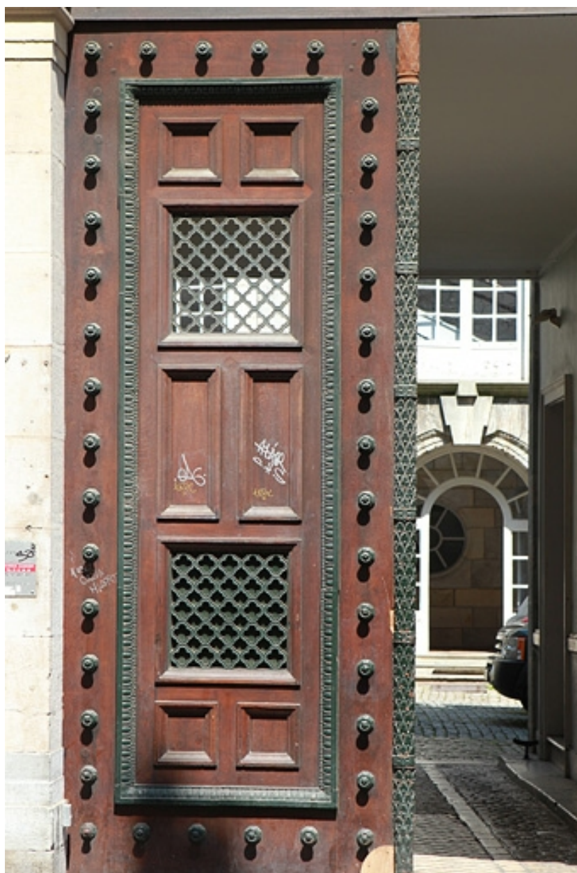
Détail d'un vantail du portail d'entrée.
