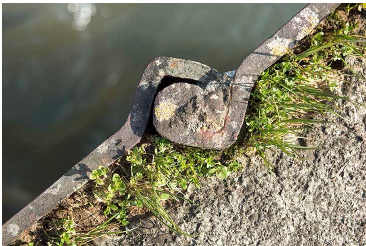
Détail d'assemblage (serrure) des palplanches en aval du barrage mobile.
