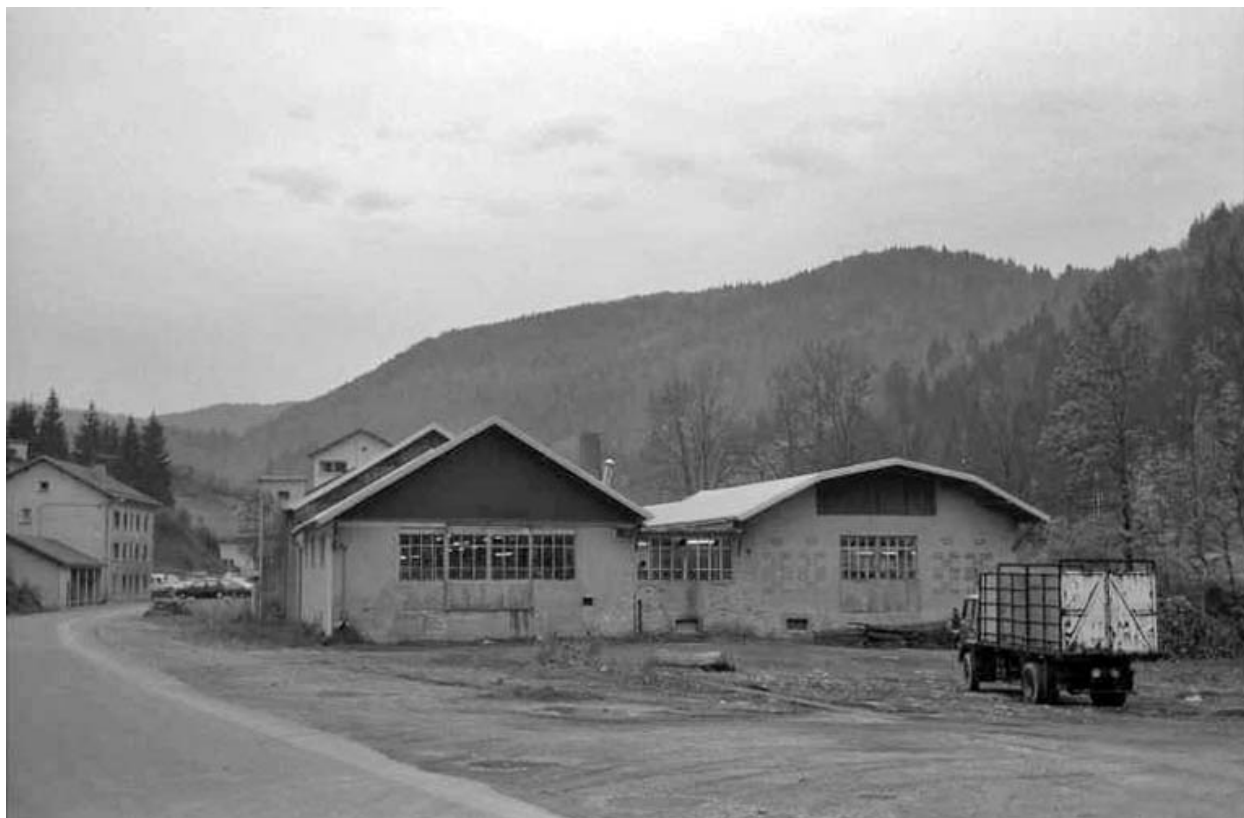
Vue d'ensemble de la façade postérieure.
