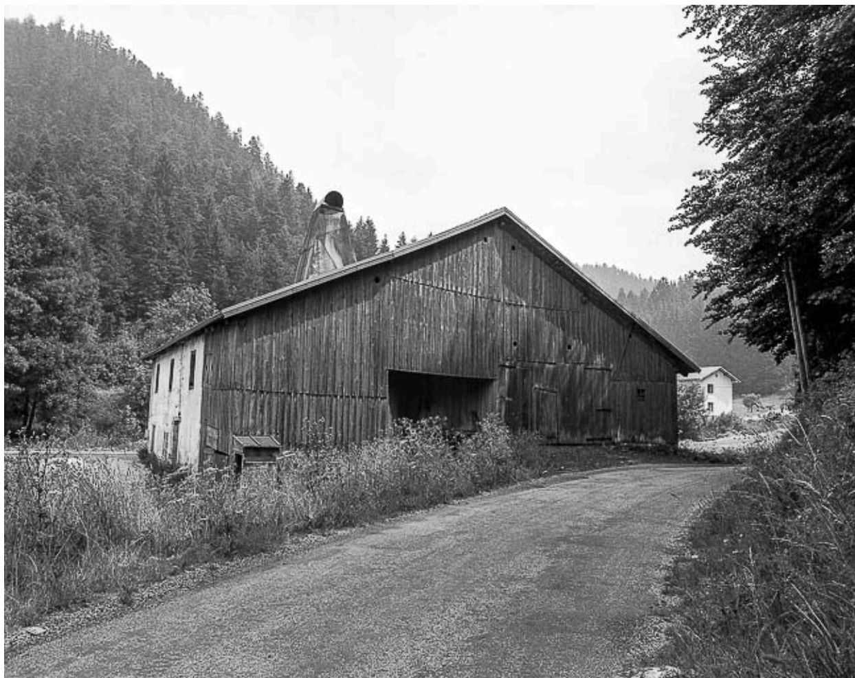
Ferme située au lieu-dit Le Dessus de la Fin, cadastrée A1 115 : facade latérale droite.
