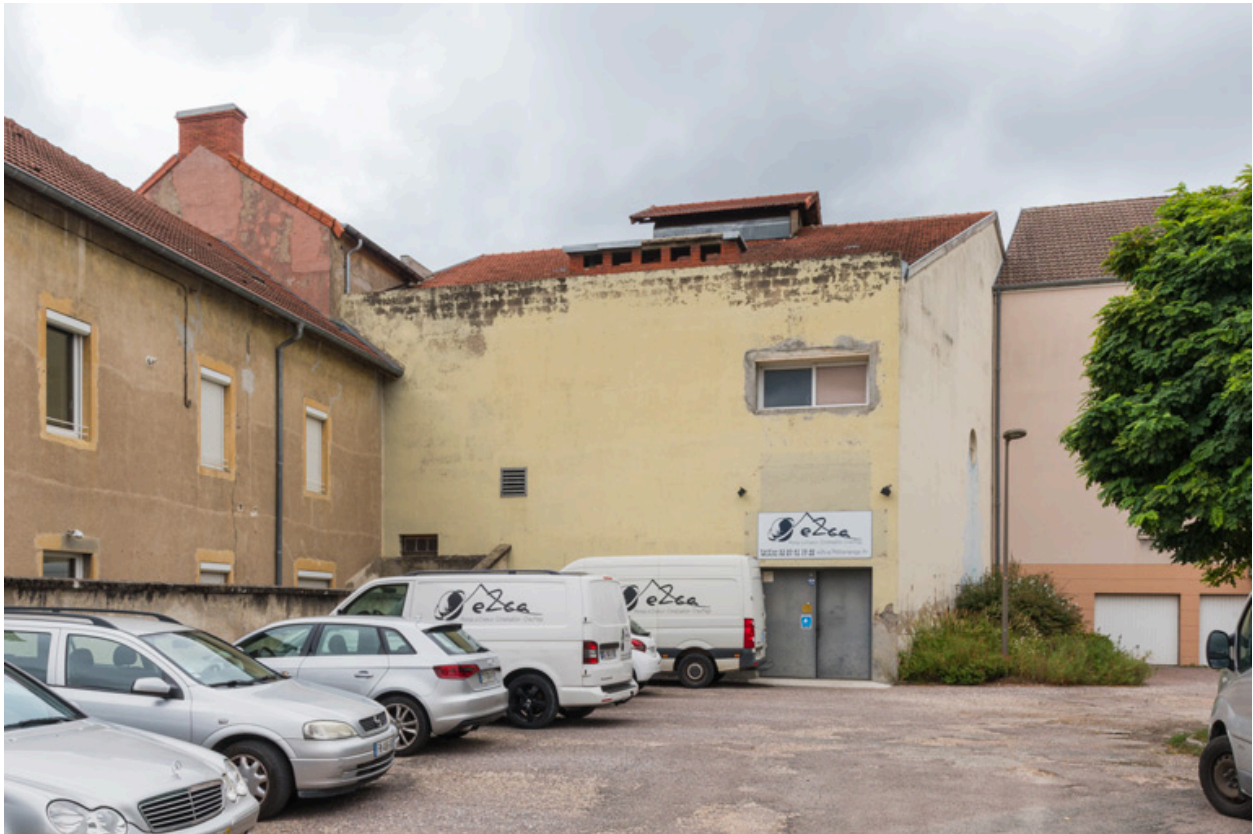
Façades latérale droite et postérieure.
