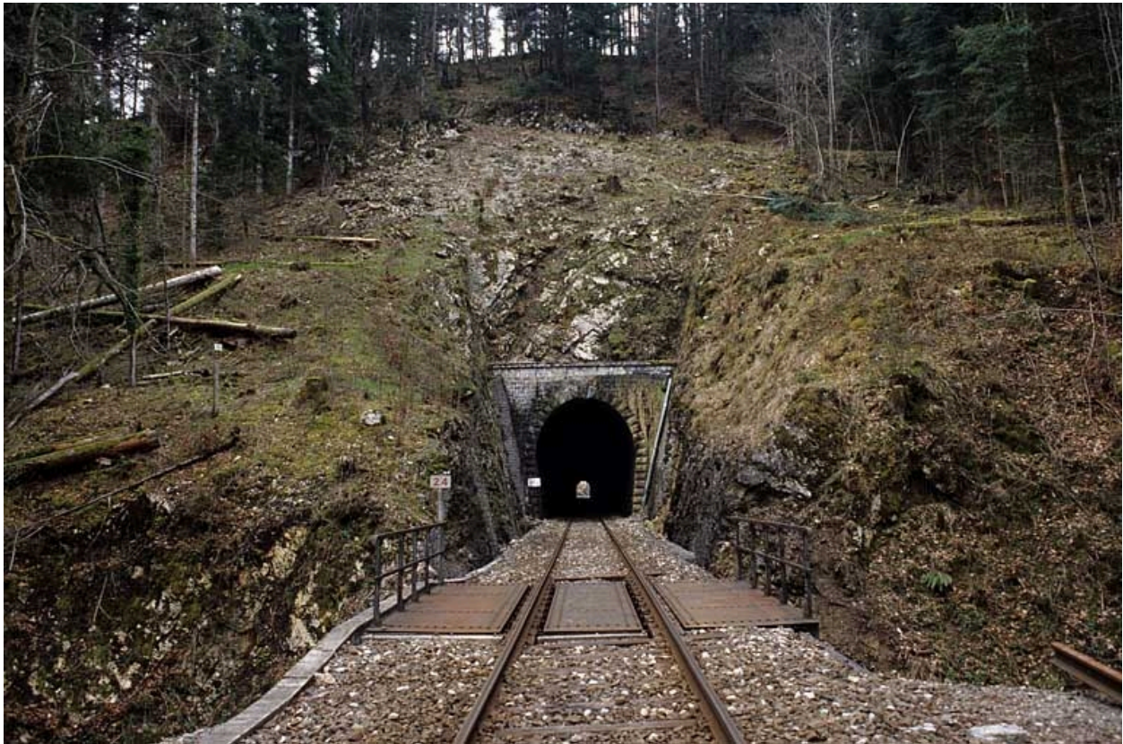
Pont et tunnel, depuis la plate-forme côté Andelot-en-Montagne.
