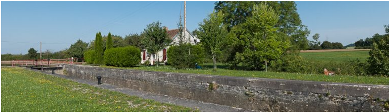
Vue d'ensemble du site d'écluse.
