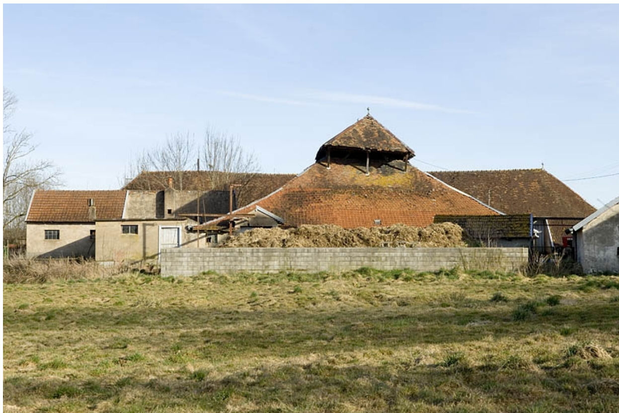
Bâtiment du four et séchoir depuis l'ouest.
