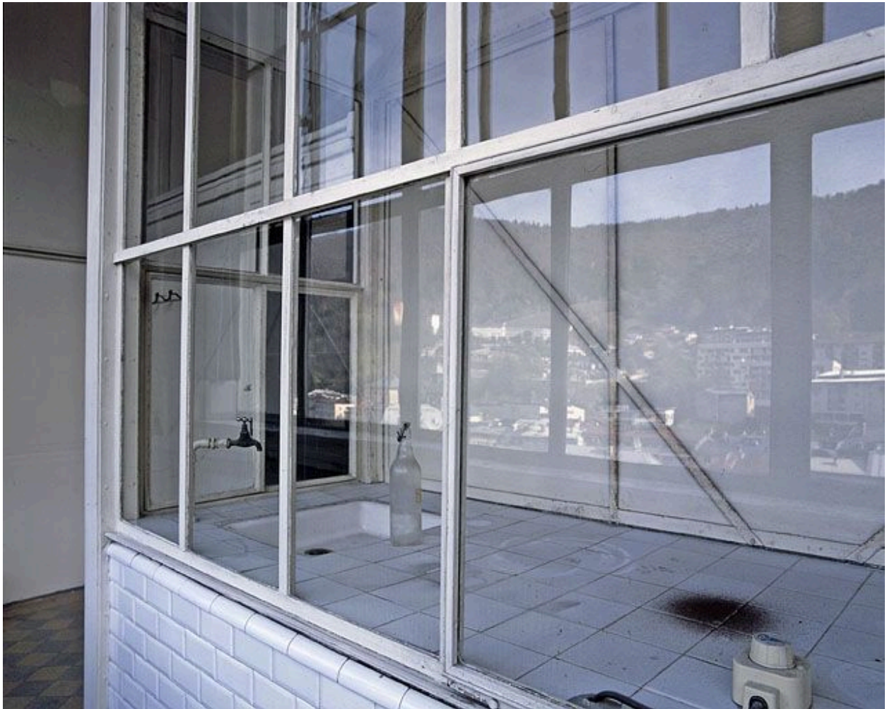
Bâtiment B, amphithéâtre de sciences : détail de la sorbonne de laboratoire.
