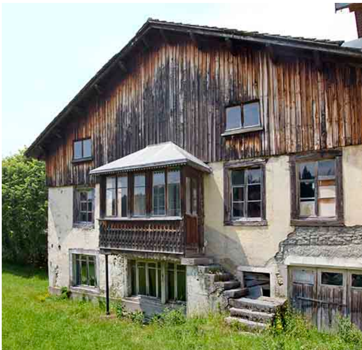
Logement d'ouvriers : façade antérieure.
