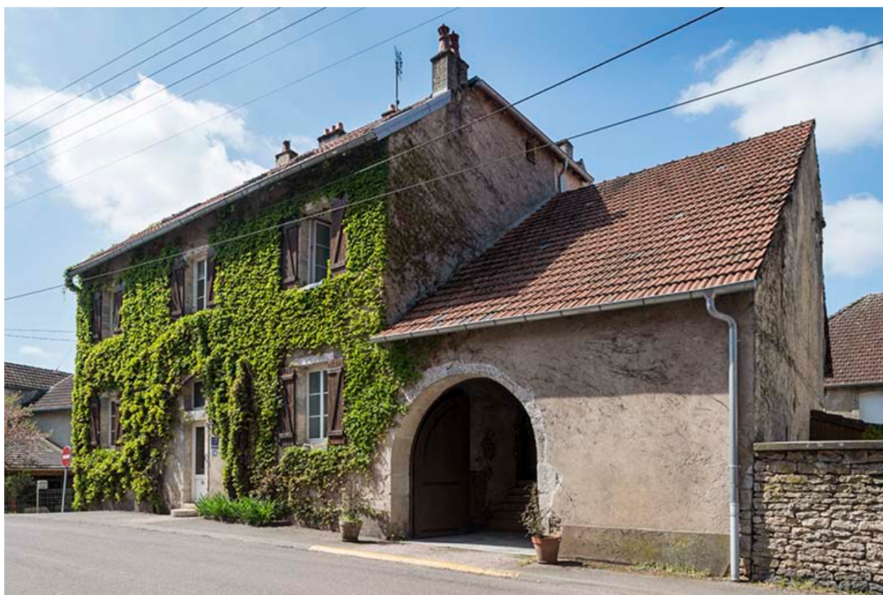
La grange, adossée au mur pignon Nord.
