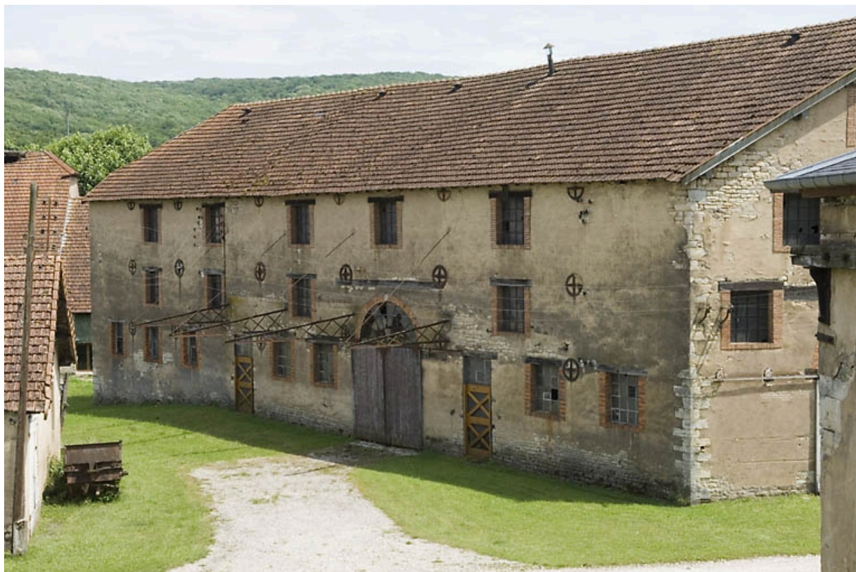
Façade ouest du magasin industriel (fonderie).
