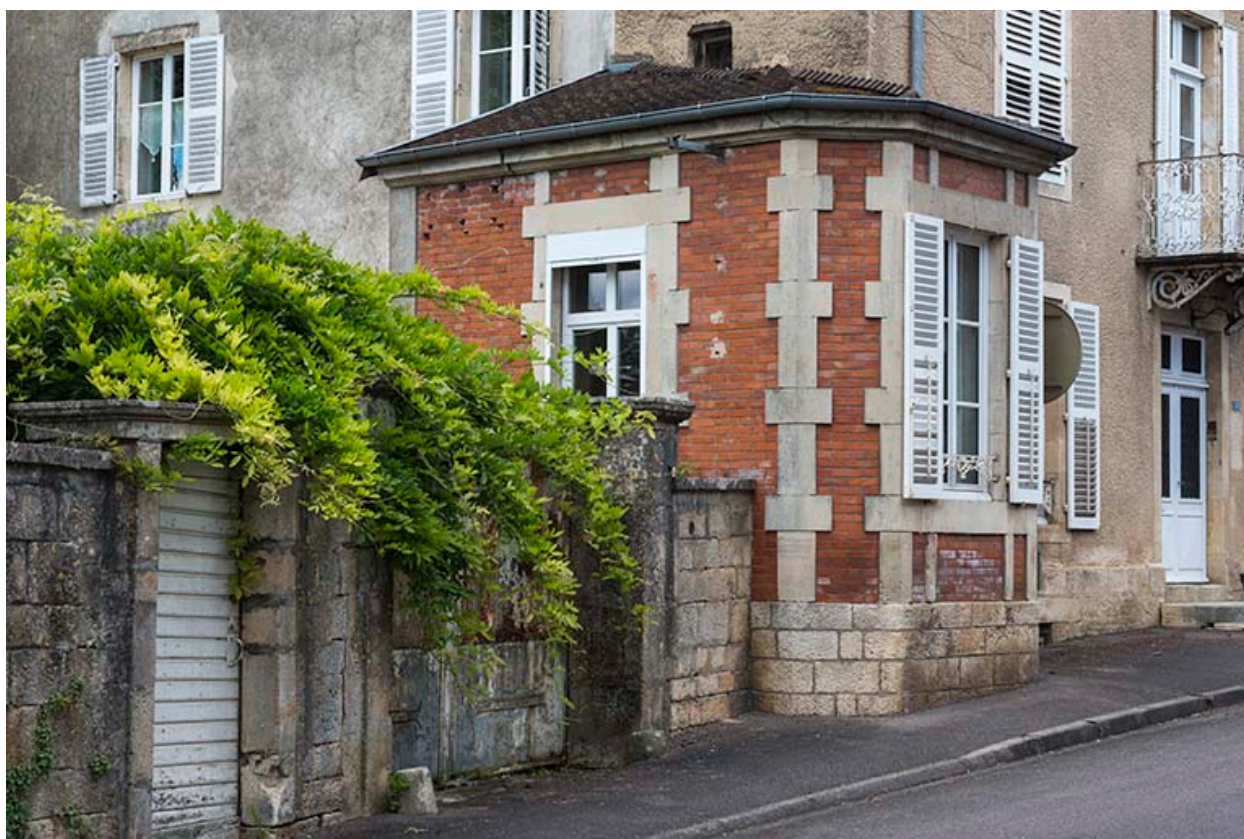
Le pavillon en brique, détail.
