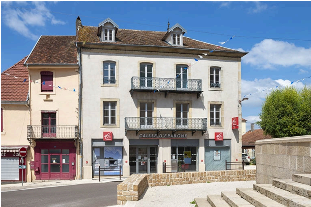
Façade de la maison.
