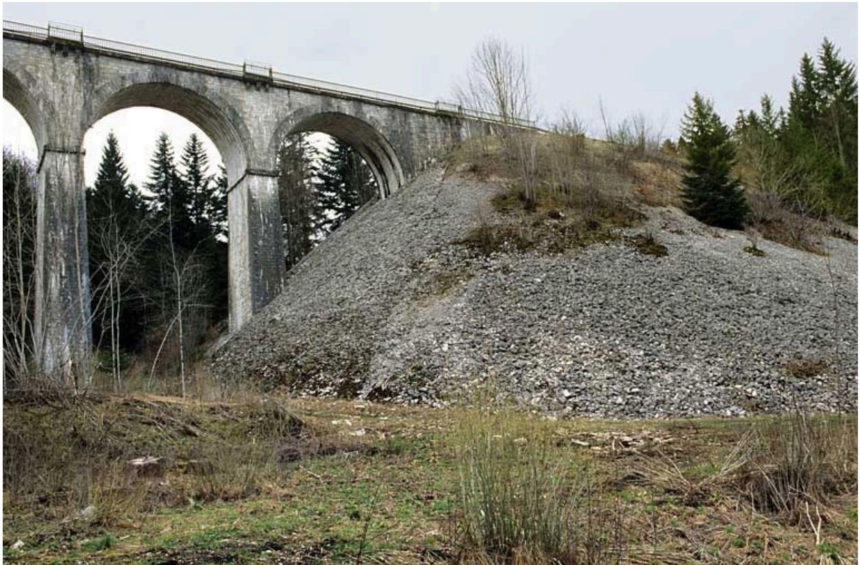
Extrémité et quart de cône côté Andelot-en-Montagne, depuis l'est.
