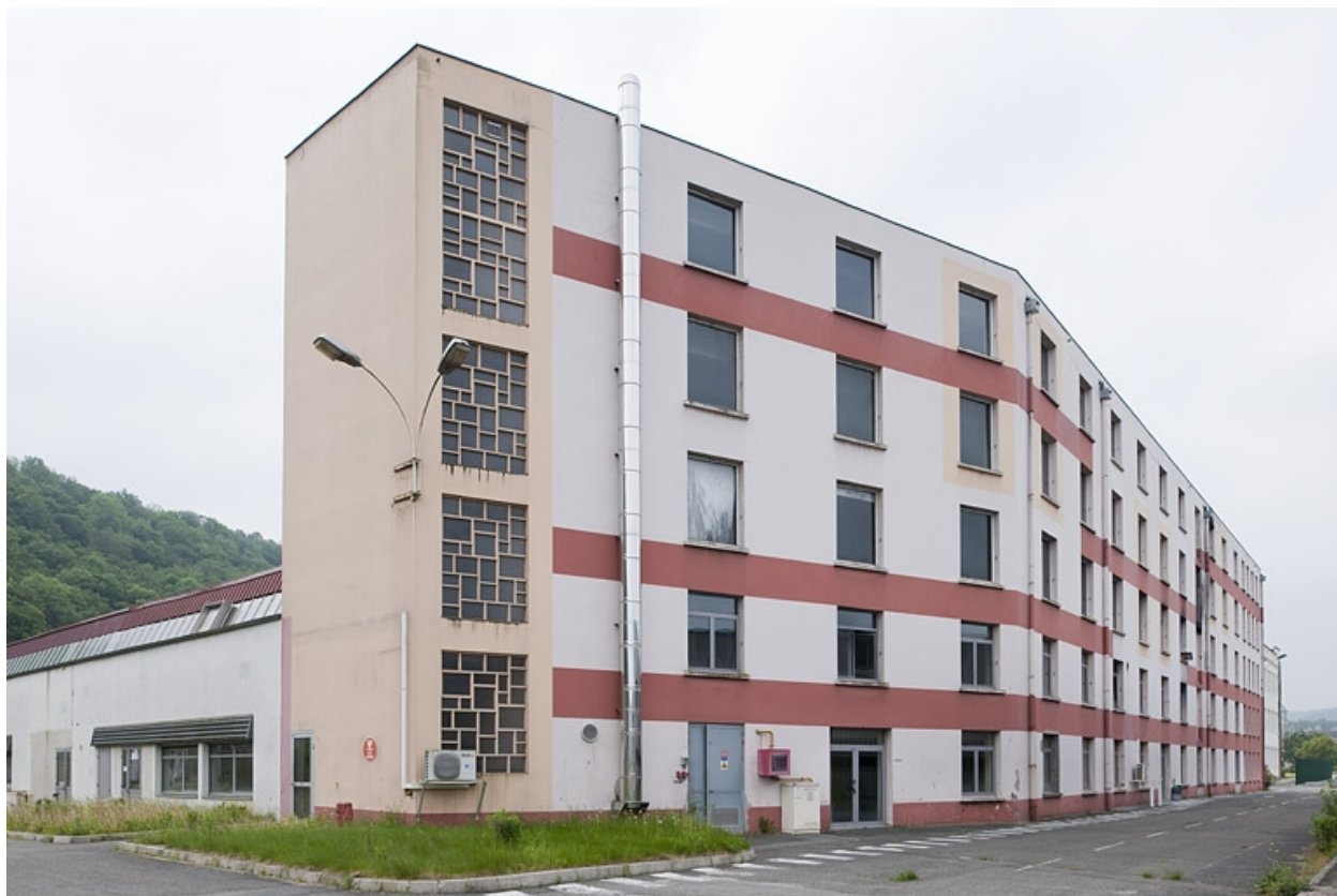
Bâtiment administratif. Façade nord-ouest.
