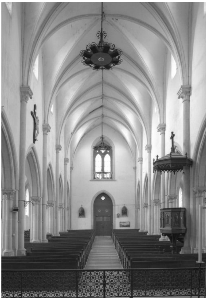
Vue intérieure prise du chœur
