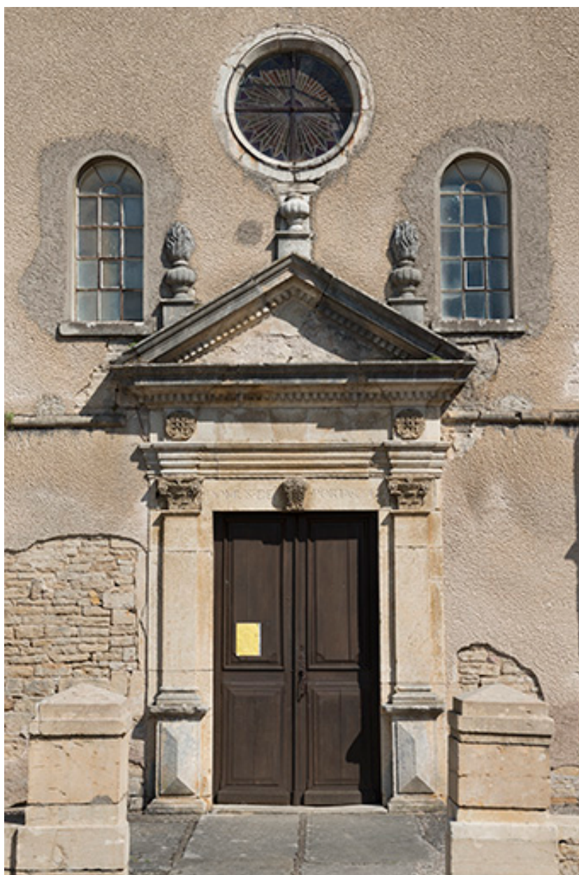
Vue avant restauration (2016).
