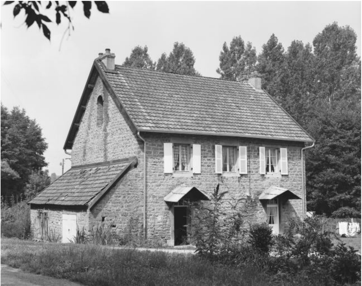
Logement d'ouvriers (B) en 1980.
