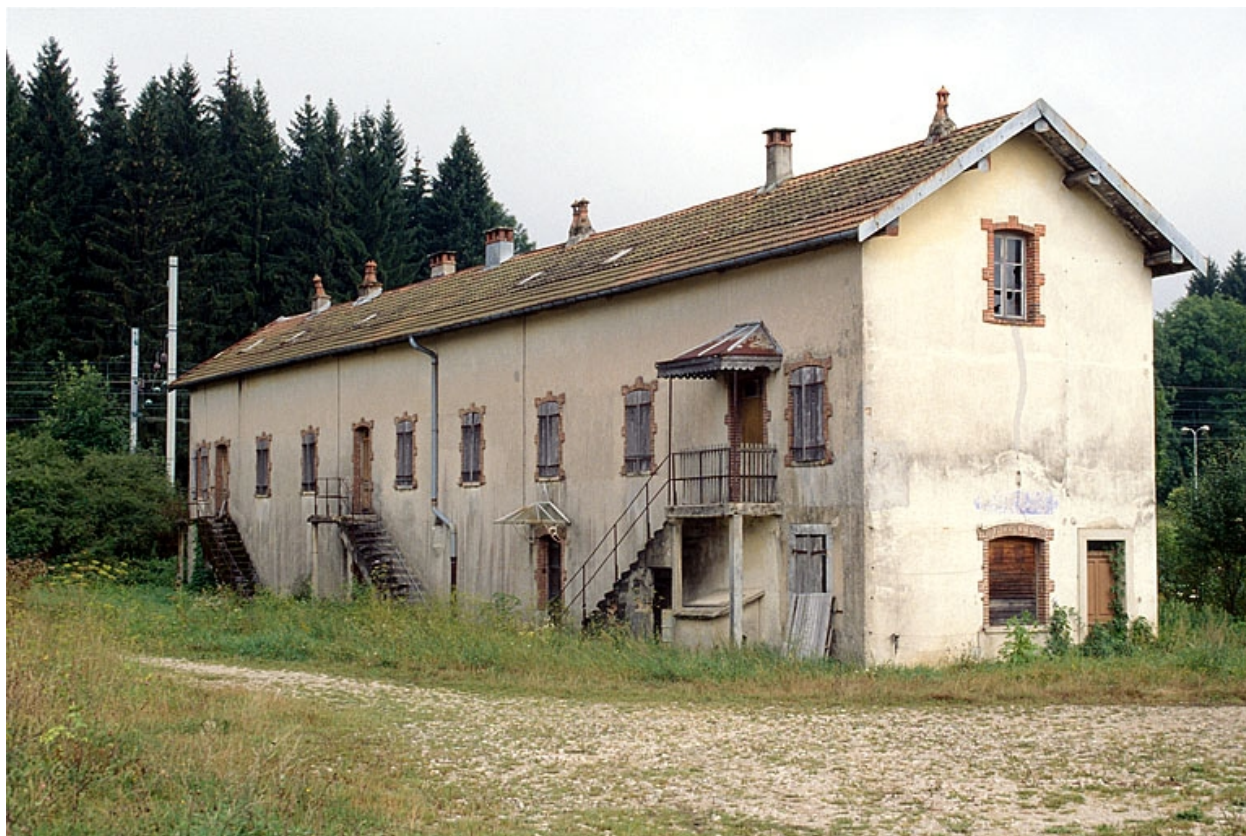
Façade antérieure du logement ouvrier.
