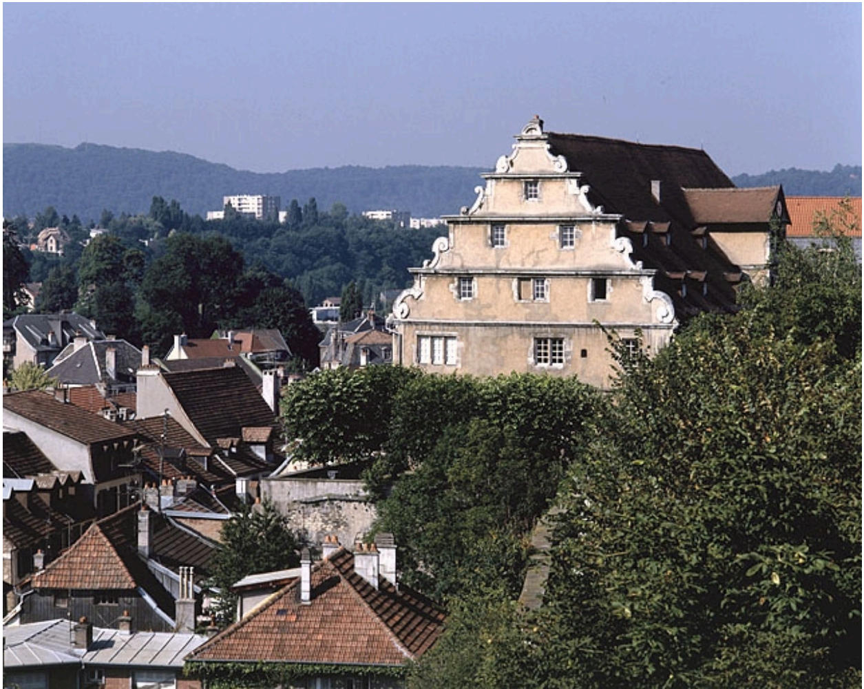
Façade latérale est.
