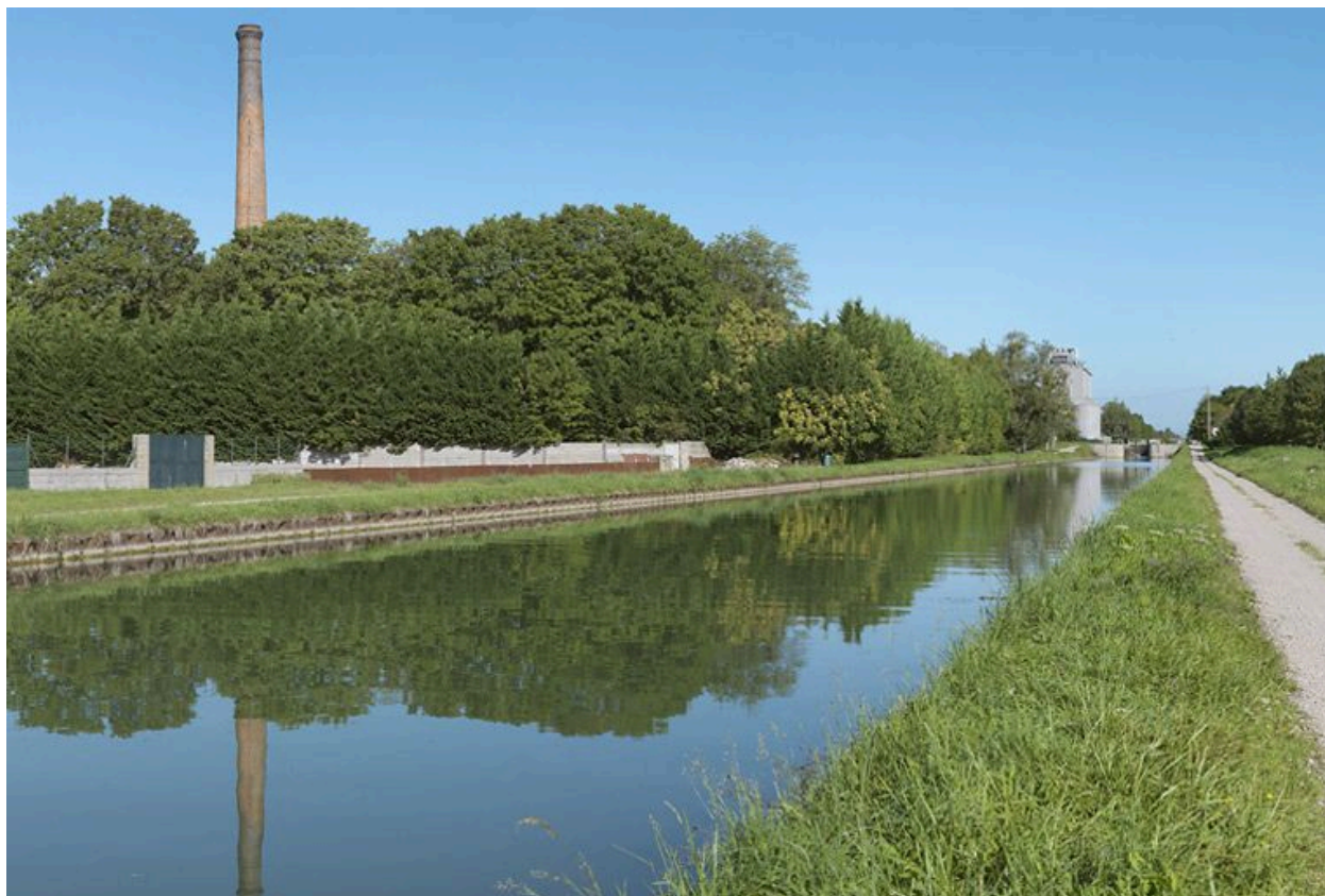
La cheminée de l'usine.
