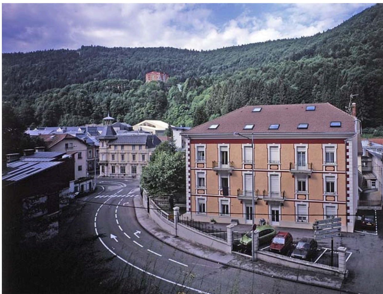
Vue d'ensemble plongeante, depuis l'est.
