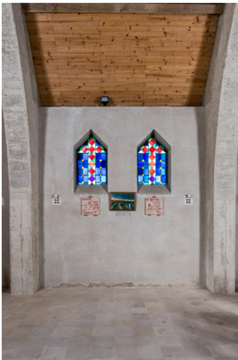
Nef, détail d'une travée.
