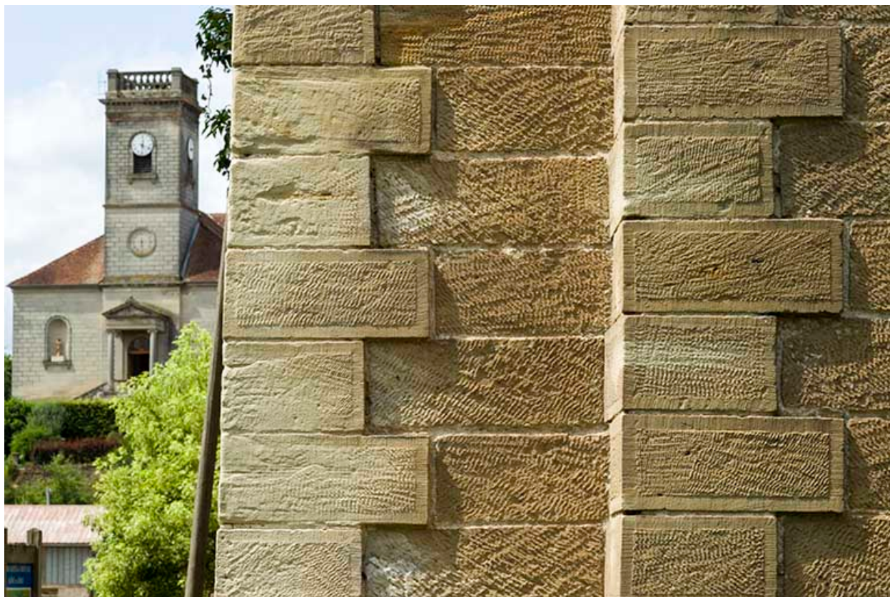
Détail de la maçonnerie des piles du viaduc.
