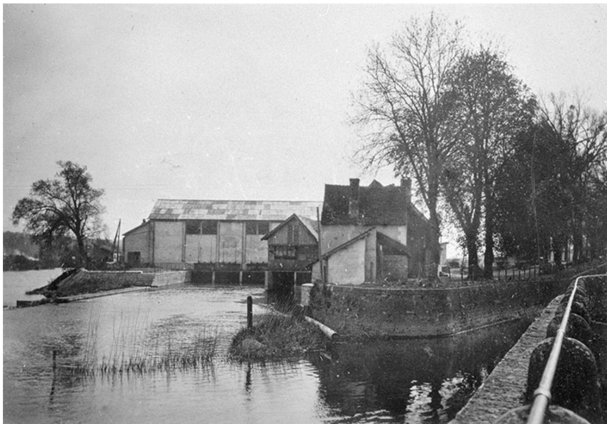
Station et moulin. Côté canal d'amenée.
