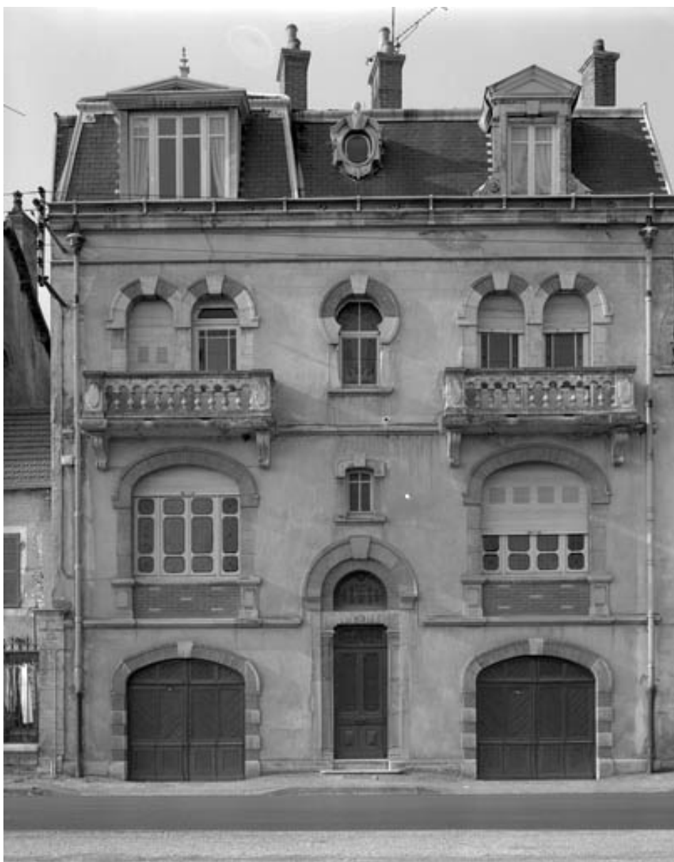
Façade antérieure de face, vue rapprochée.
