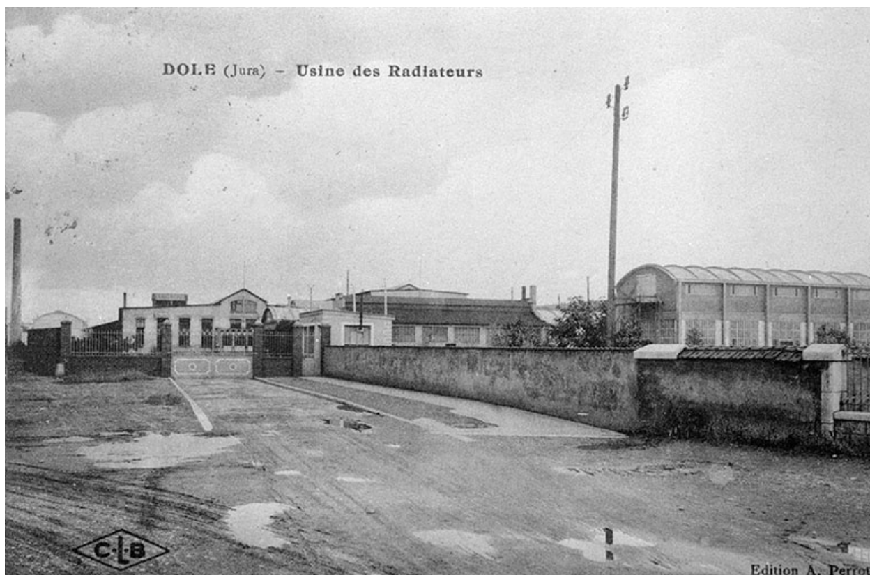
Dole (Jura) - Usine des radiateurs.
