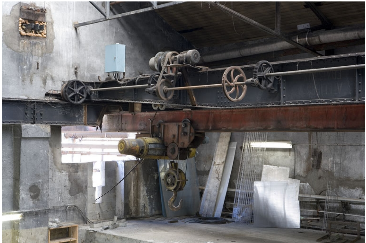
Transformateur électrique. Le pont roulant et son système d'entraînement.
