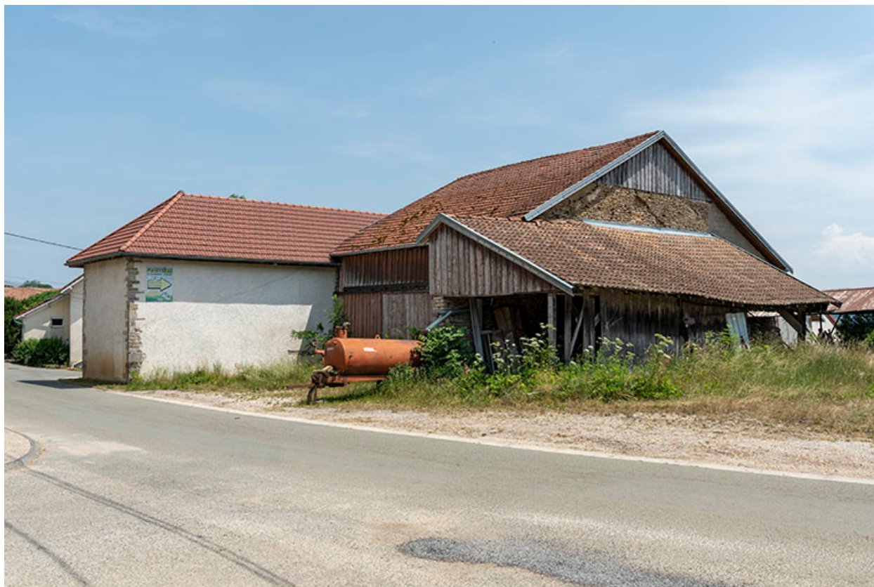
Cave d'affinage (façade postérieure), grange et hangar.
