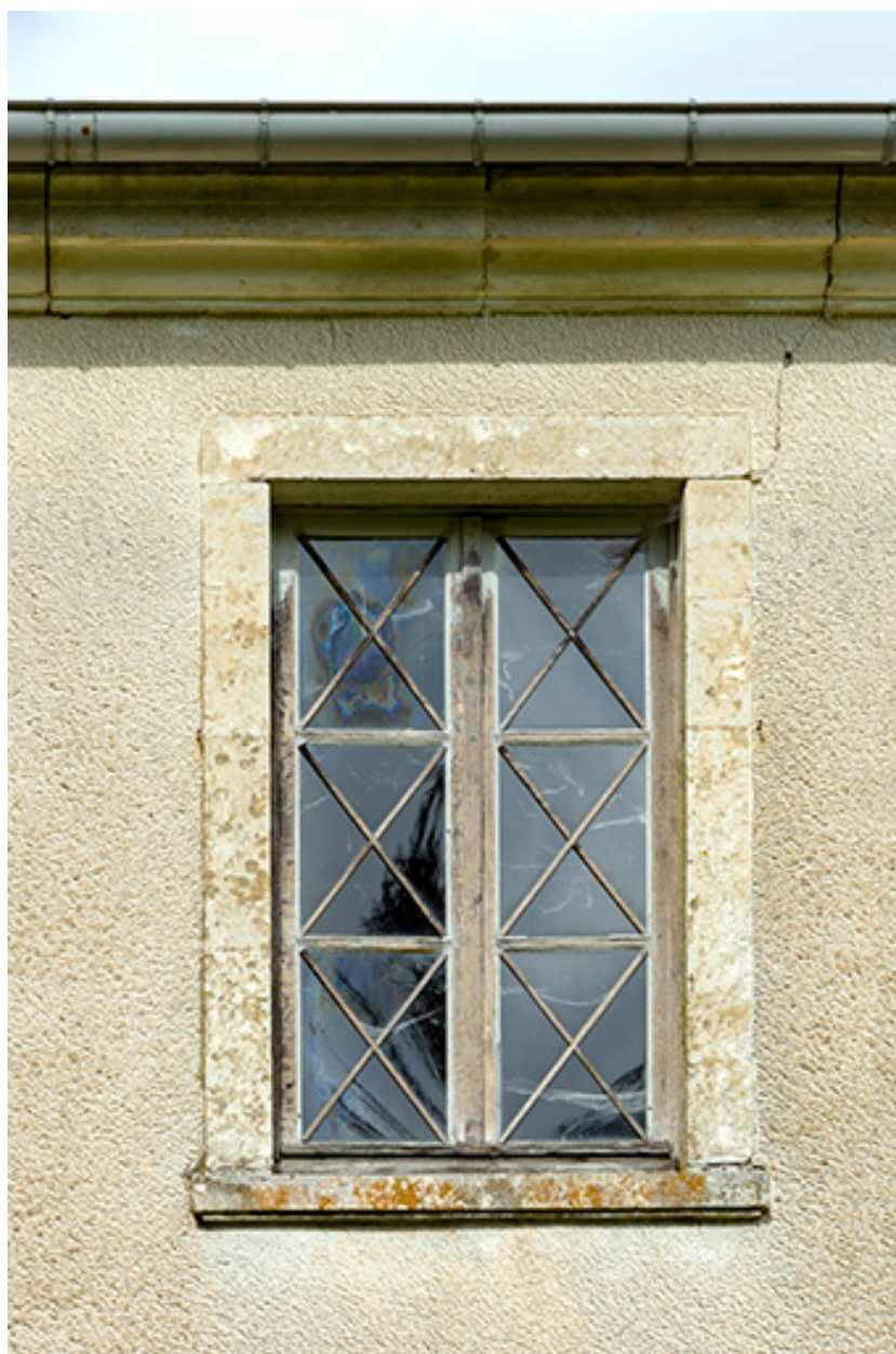
Etable, façade sud-ouest : détail d'une des baies du 1er étage.
