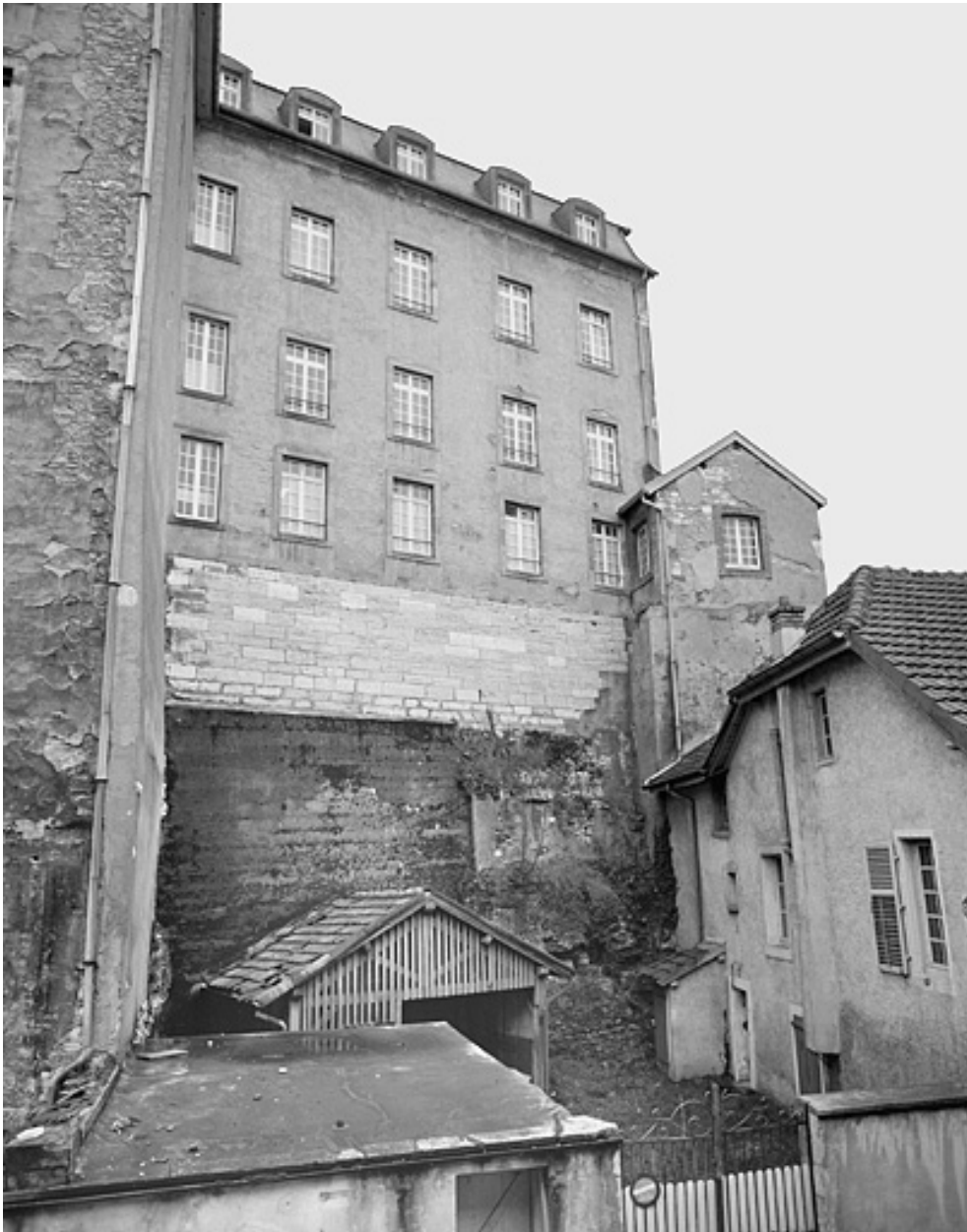
Enceinte. Partie sous le Vieux Château (e).
