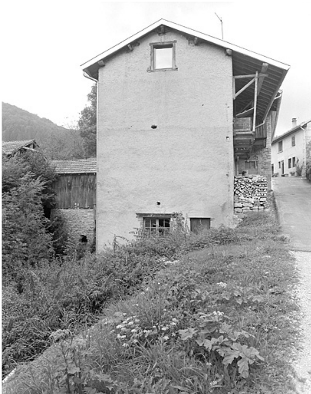
Face gauche de l'atelier de tournerie.
