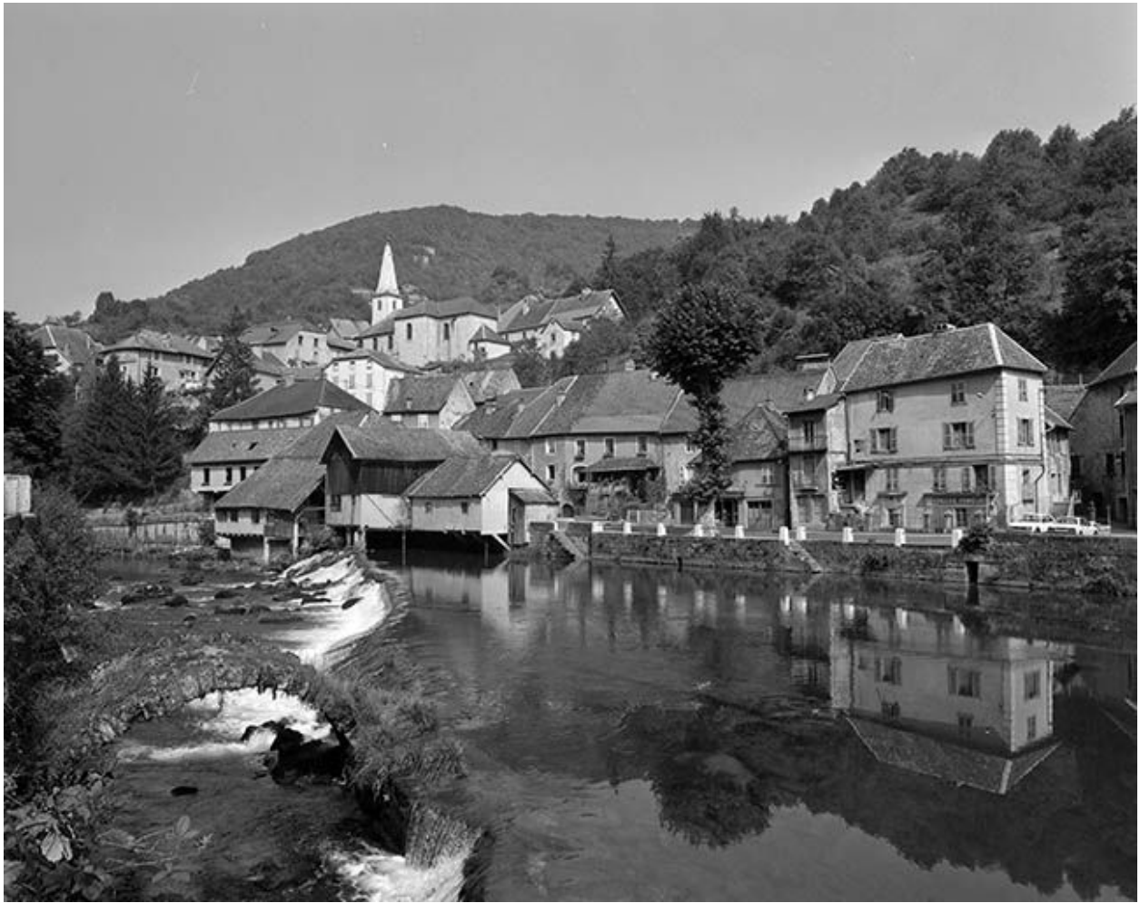
Vue du village depuis le sud-est.
