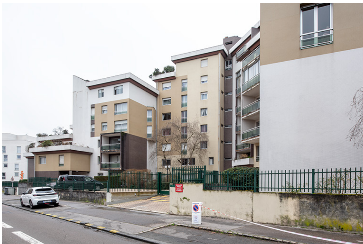
Aile nord, façade est.
