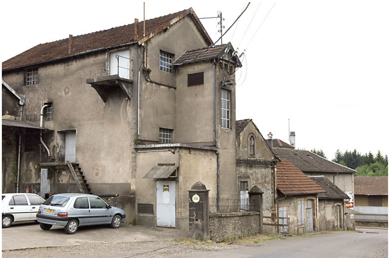
Façades sur la rue des Moines Hauts.
