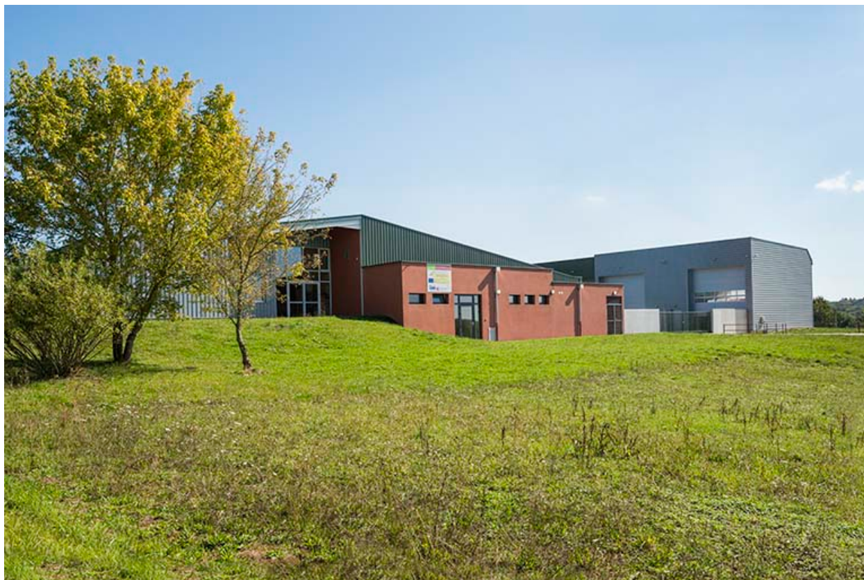
Les deux halles vues du nord-ouest.
