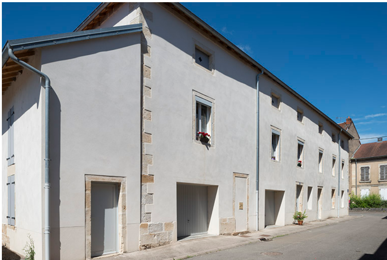
Élévation extérieure sur la rue des Forges.
